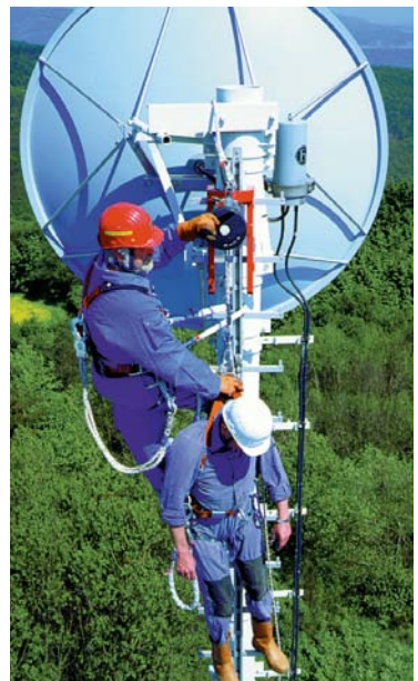
Abb. 8 Abseilgerät mit integrierter Hubeinrichtung
