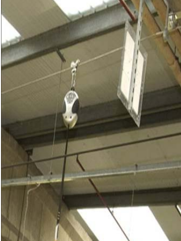
Abb. 16 Anschlagrichtung mit horizontalem Führungsseil
