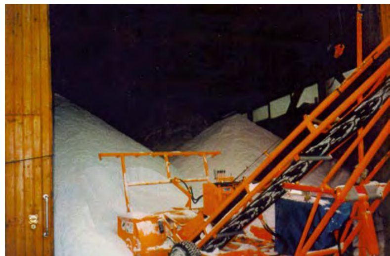
Abb. 9 Streuguthalle mit Salzladeförderband
