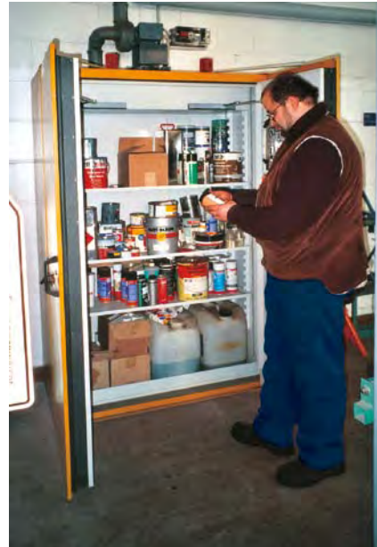
Abb. 1 Lagerung brennbarer Flüssigkeiten in einem Sicherheitsschrank
