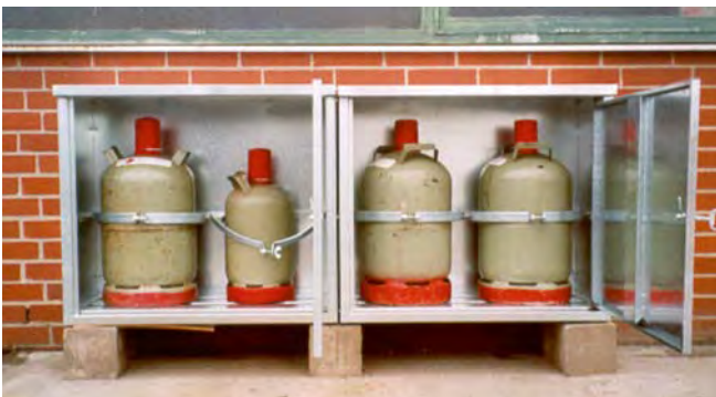
Abb. 4 Kleinlager für Flüssiggasflaschen
