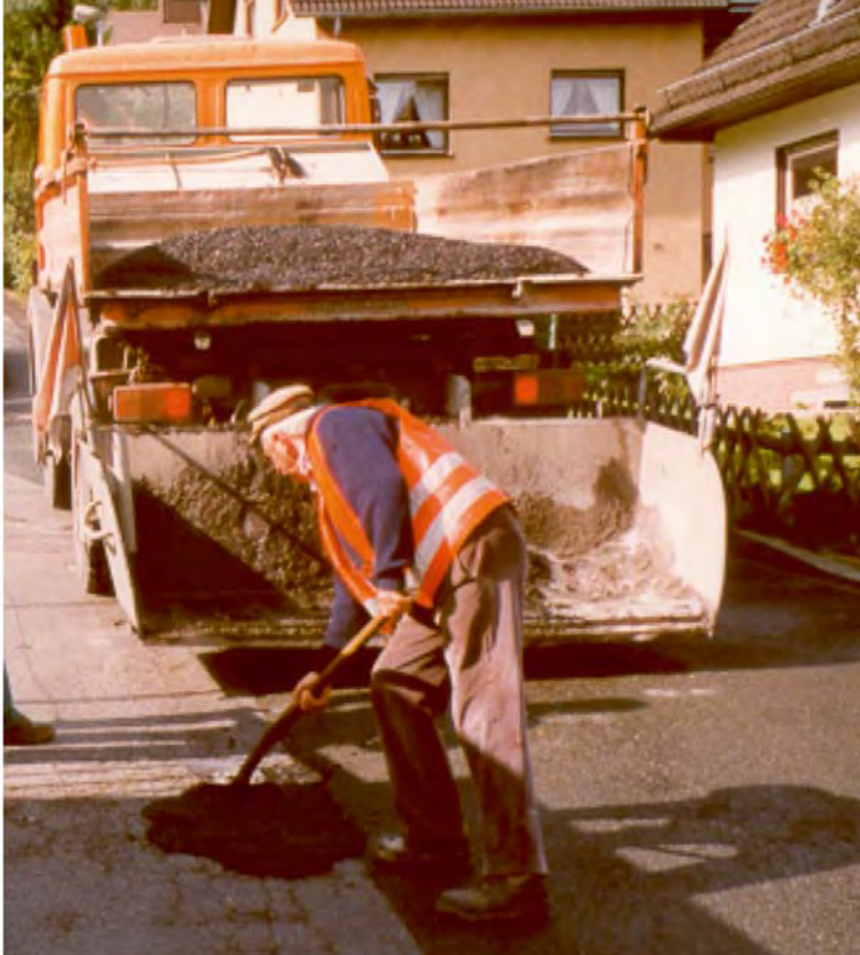
Abb.8 Straßenausbesserungsarbeiten mit Bitumen
